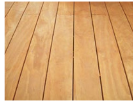
マクセラム施工後
