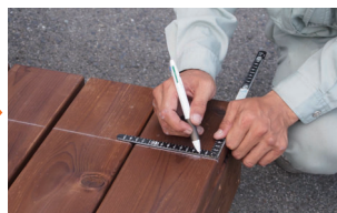
印をつけた位置に沿って、ビス穴を開けるポイントに目印を入れ、下穴を開けます。
