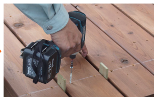
目地幅に合った薄い木片などをスペーサーとして使い、床板を固定します。
